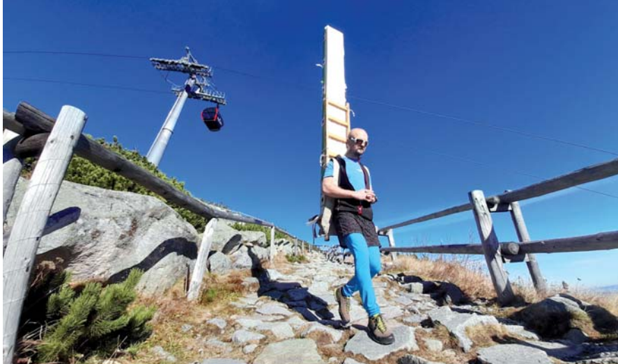
Materiál na rekonštrukciu nosil chatár na vlastnom chrbte.
