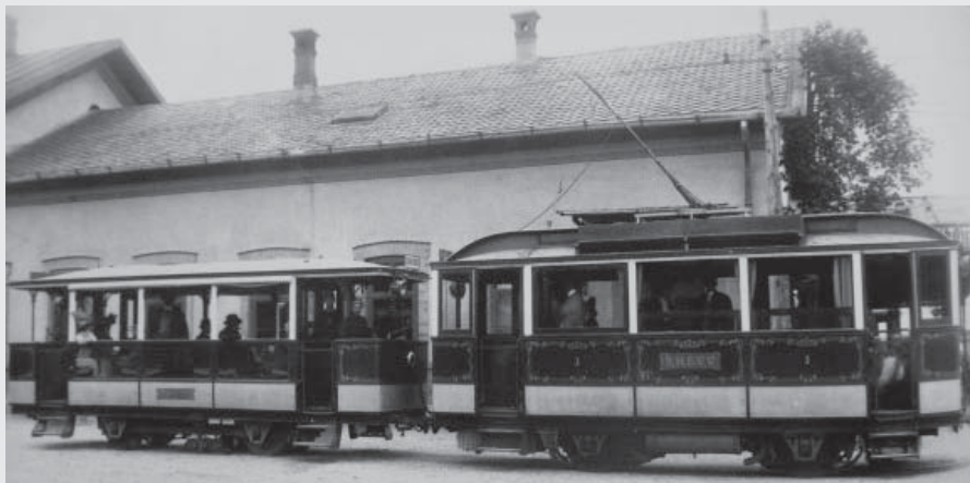
Takto vyzerali prvé súpravy ešte z roku 1908. Zachoval sa malý letniáčik, ktorý je dnes súčasťou historickej súpravy. Pôvodne bol objednaný ešte spoločnosťou Kriegera a Matejku na rozchod 760 mm.
