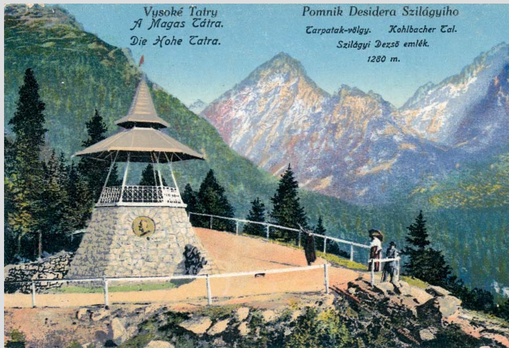
Szilágyiho pavilón stojí v ohybe poslednej zákruty cesty zo Starého Smokovca na Hrebienok. Postavili ho podľa projektu spišskosobotského architekta Gedeona Majunkeho a slúžil ako rozhľadňa. Do užívania verejnosti ho odovzdali 7. augusta 1904.
