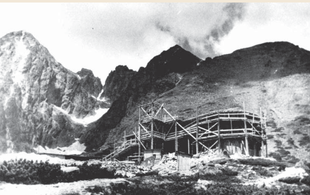
Stavba observatória (jún 1942)
