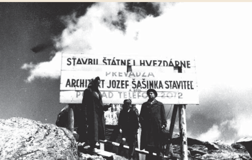
Stavenisko na začiatku výstavby (apríl 1941)
